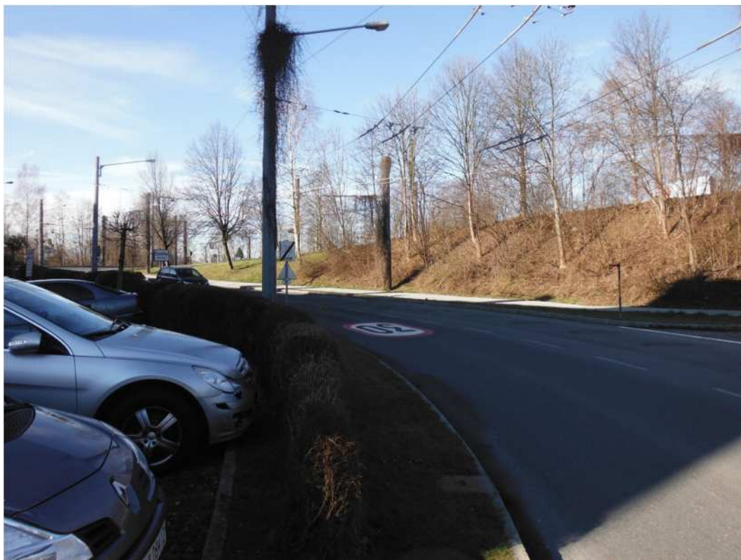
Foto 3 Zufahrtsstraße zur S-Bahn Haltestelle Salzburg Süd und Anfangsbereich der geplanten Haltestelle im Böschungsbereich zur L 106 (Stützmauern erforderlich)
