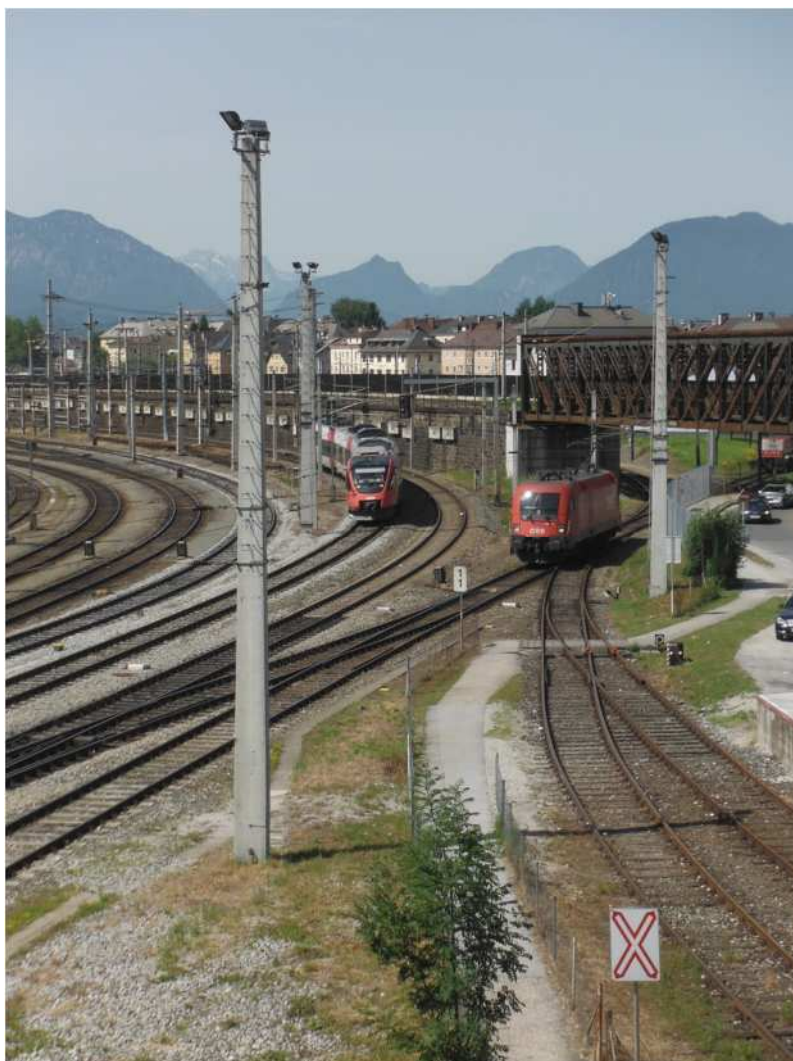
Foto 7 Beispiel für Nutzung des ÖBB-Gleises im Fortsetzung zum Überstellgleis SLB im Bereich der Bahnüberführung Westbahn
